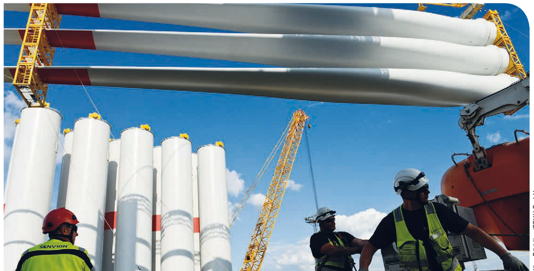
➤ Verladung von Offshore-Komponenten in Cuxhaven
