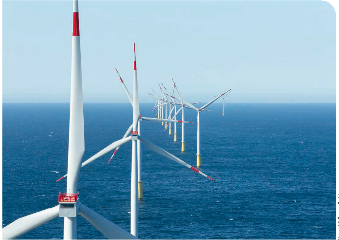
> Die Anlagen des neu in Betrieb genommenen Offshore Parks DanTysk
