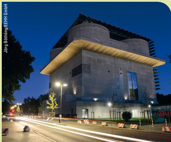
> Energiebunker bei Nacht
