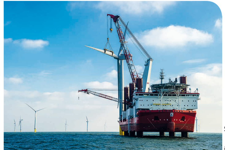
> Installation der letzten Windturbinen in London Array
