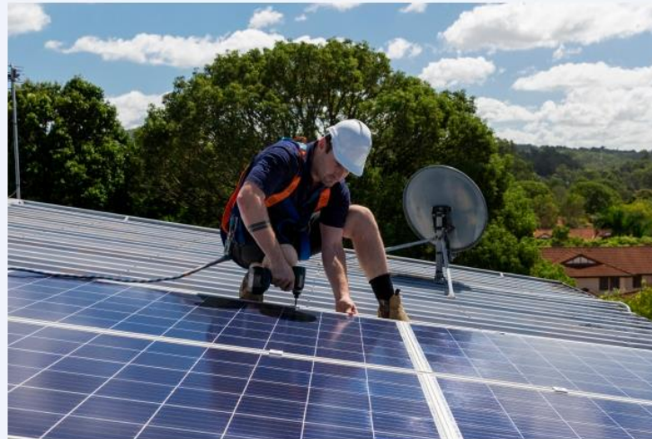
SOLARENERGIE AUF DEM FIRMENDACH MIT FINANZIERUNG VON DER GLS BANK
