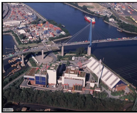
Beispiel 4: Müllverbrennungsanlage Rugenberger Damm
